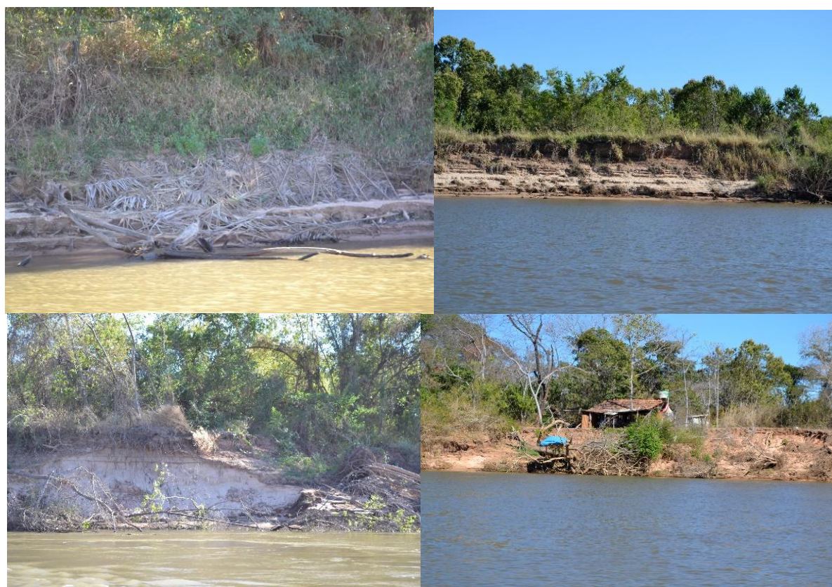
Figura 12- Palhas retiradas da cobertura dos acampamentos e descartada nas margens do rio Araguaia. Figuras 13 e 14- Margens do rio em avançado processo de desbarrancamento. Figura 15- Construção ribeirinha ameaçada pelo avanço da erosão causada pela lavagem das margens do rio Araguaia. Fonte: SILVA, Eliete Barbosa de Brito. 2017.
