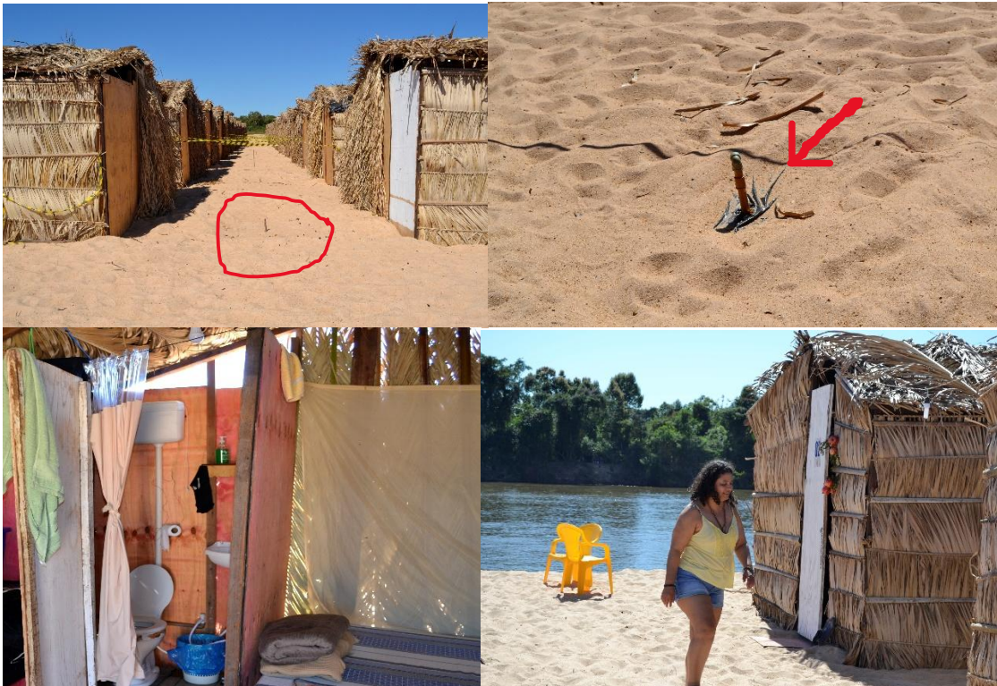
Figura 01- Estrutura dos chalés construídos no acampamento APCE-GO. Destaque para o cano “enterrado” no chão. Figura 02- Cano que serve de suspiro para as fossas entre os chalés. Figura 03- Estrutura sanitária dos chalés. Figura 04- Localização dos chalés em relação ao rio Araguaia. Fonte: SILVA, Eliete Barbosa de Brito. 2017.
