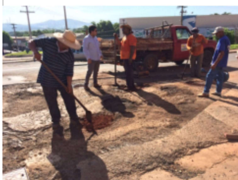
Figura 7: Colocação de terra
