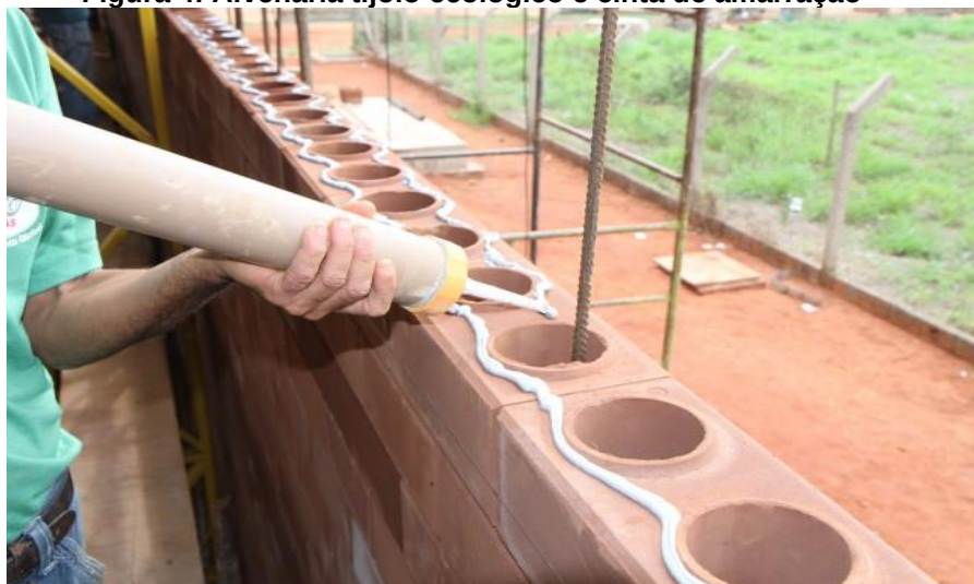
Figura 4: Alvenaria tijolo ecológico e cinta de amarração
