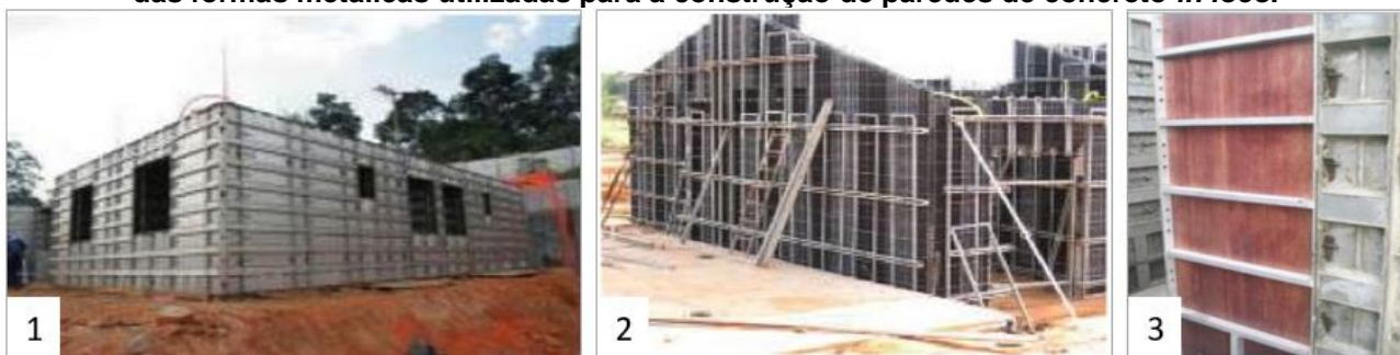
Figura 1 – (A) Exposição de formas metálicas; (B) Montagem de formas metálicas; (C) Detalhamento das formas metálicas utilizadas para a construção de paredes de concreto in loco .
