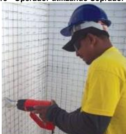
Figura 15 - Operador utilizando Soprador Térmico
