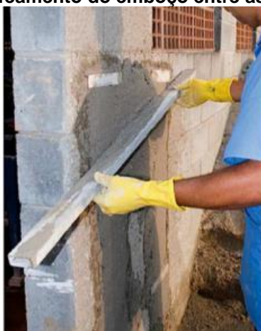
Figura 7 -Sarrafeamento do emboço entre as faixas-mestras
