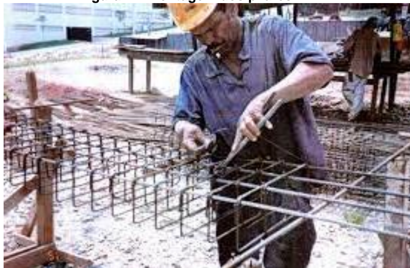
Figura 1 – Montagem dos pilares
