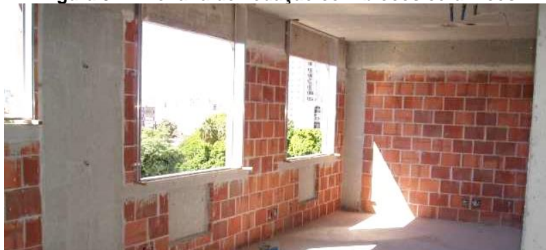
Figura 5 - Alvenaria de vedação com blocos cerâmicos
