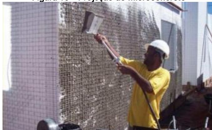
Figura 16 – Projeção do microconcreto
