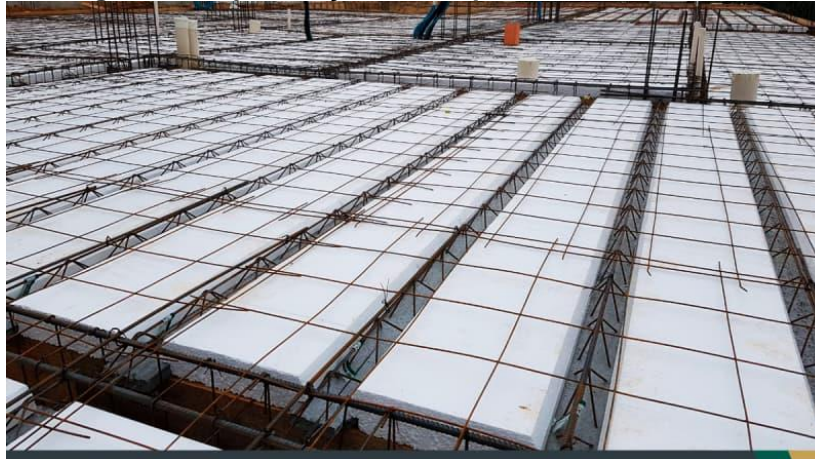
Figura 4 – Lajes treliçadas com preenchimento de EPS
