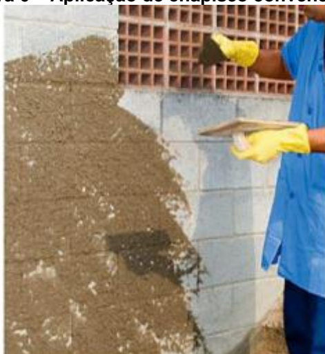
Figura 6 – Aplicação de chapisco convencional
