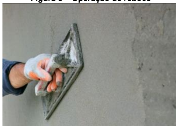
Figura 8 – Operação de reboco
