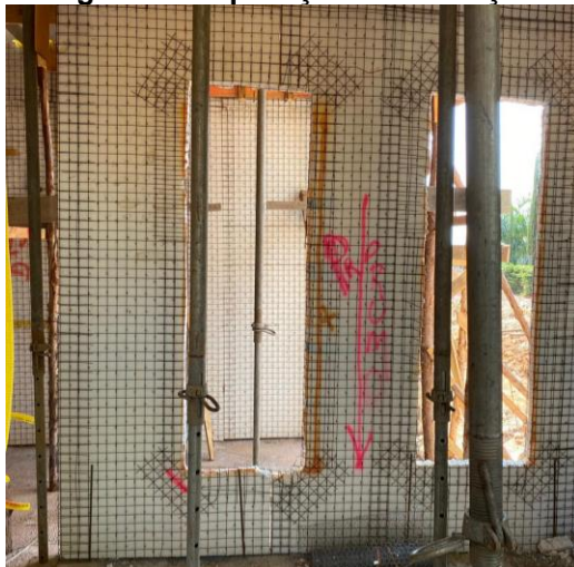
Figura 14 - Aplicação dos reforços
