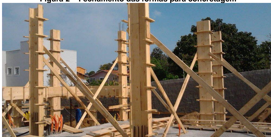
Figura 2 – Fechamento das formas para concretagem
