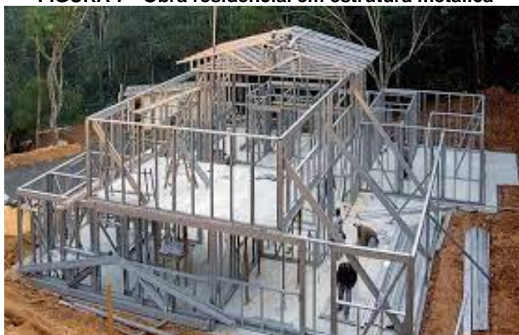
FIGURA 7 - Obra residencial em estrutura metálica
