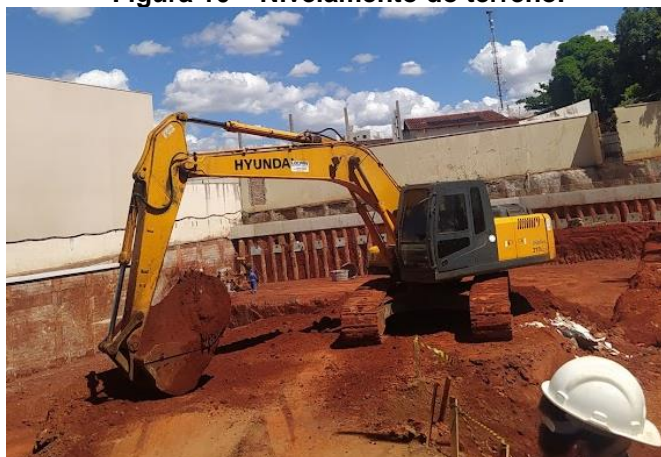
Figura 10 – Nivelamento do terreno.
