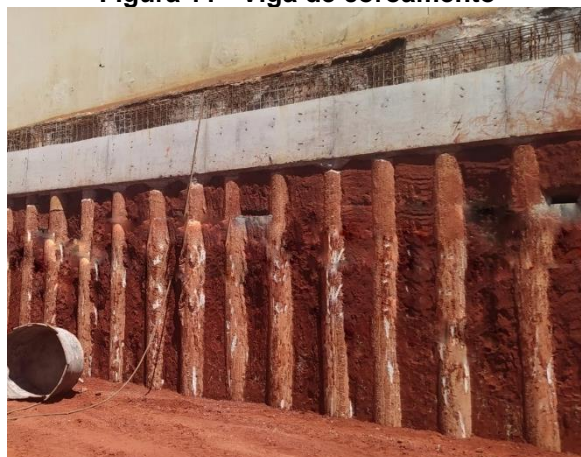
Figura 11 - Viga de coroamento
