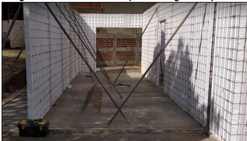
Figura 8 – Escoras utilizadas para montagem dos painéis
