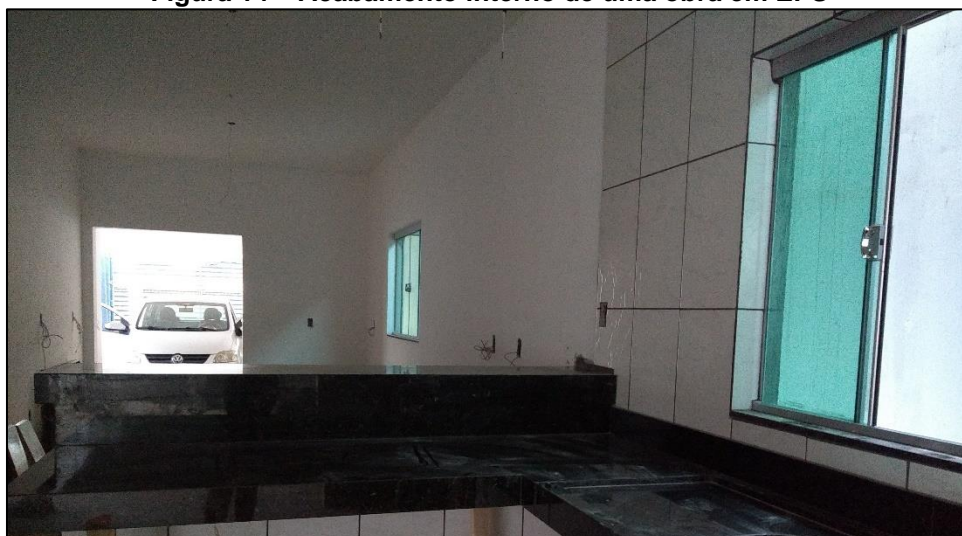
Figura 14 – Acabamento interno de uma obra em EPS
