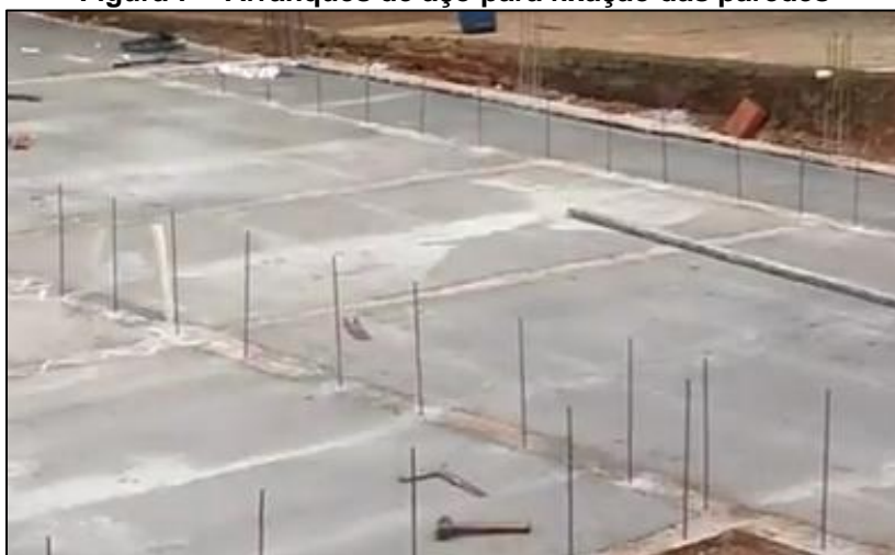
Figura 7 – Arranques de aço para fixação das paredes
