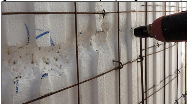
Figura 9 – Processo de abertura para passagem de tubulações
