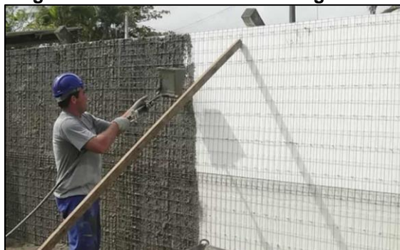
Figura 12 – Revestimento com argamassa
