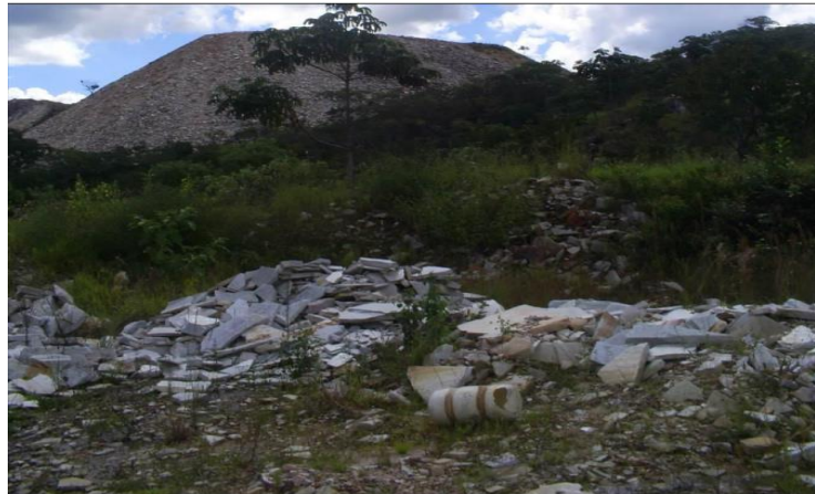
Figura 3 - Foto das pilhas de rejeitos (no primeiro plano e ao fundo) na pedreira da prefeitura (Pirenópolis- GO)
