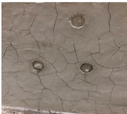
Figura 8- Deslocamento ocorrido na perfuração com serra copo
