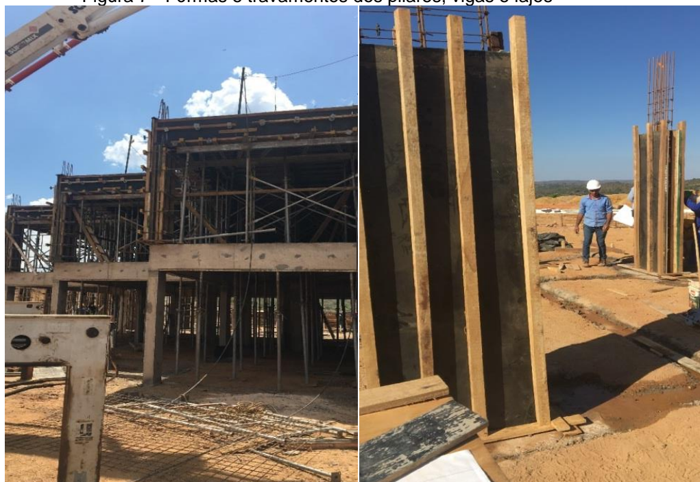
Figura 7 - Fôrmas e travamentos dos pilares, vigas e lajes
