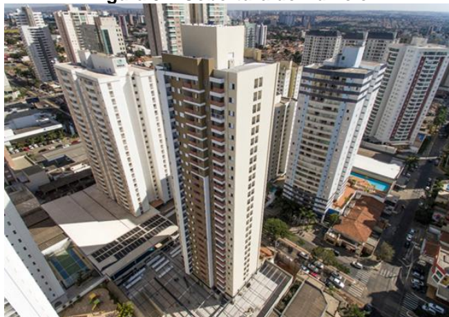
Figura 3 – Cobertura do Edifício
