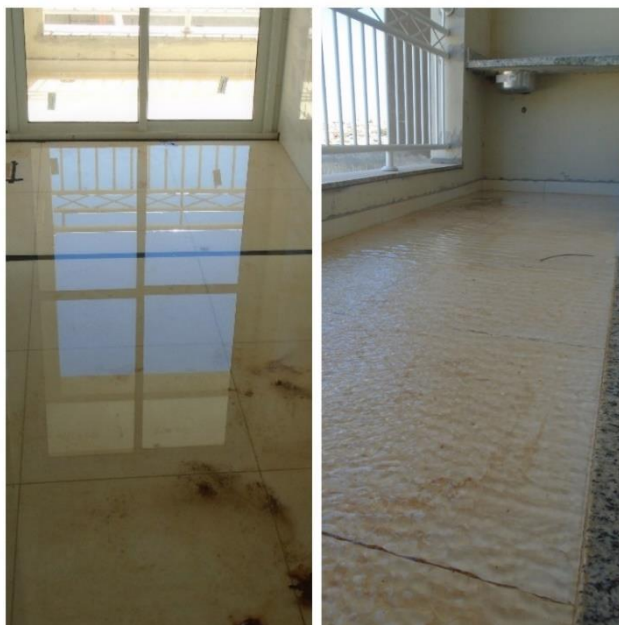
Figura 8 - Cozinha/área de serviço e varanda com lâmina d'água
