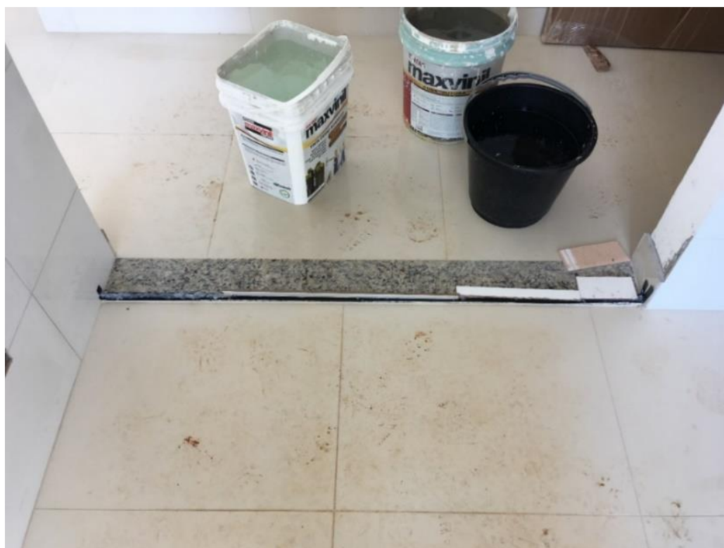
Figura 5 - Barreiras de vedação cozinha/entrada
