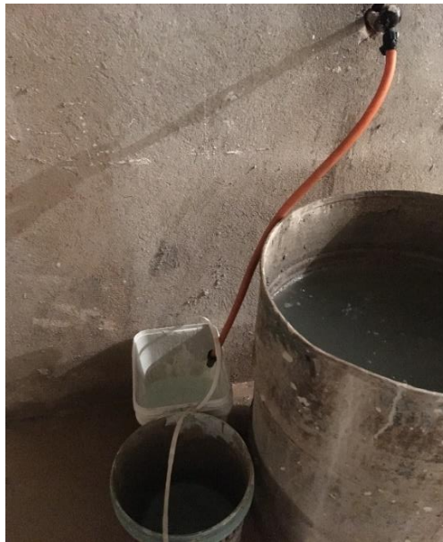
Figura 3- Abastecimento de água
