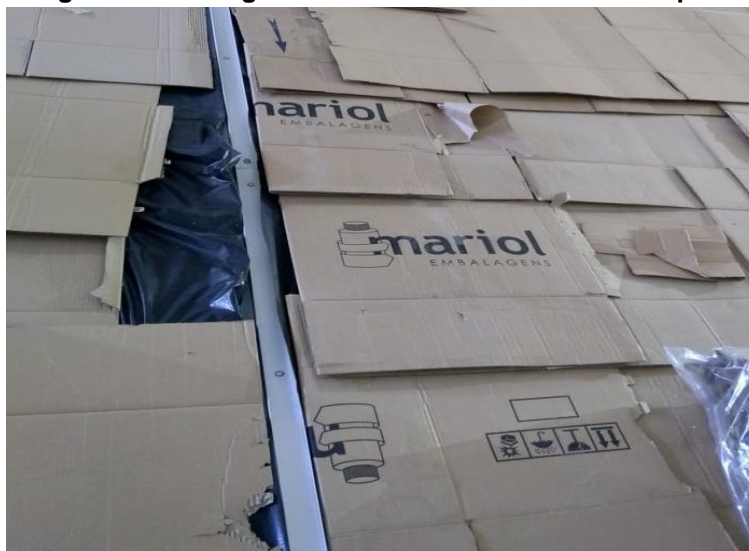
Figura 3 – Perfil guia instalado com isolamento de piso
