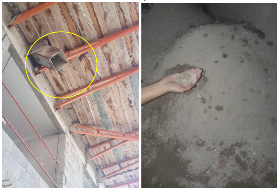
Figura 1- (a) Final do duto de descarte de resíduos; (b) Agregado reciclado triturado e peneirado
