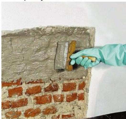
Figura 1: aplicação de cimentos cristalizantes
