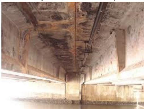
Figura 4: Deficiências que decorrem da presença de umidade
