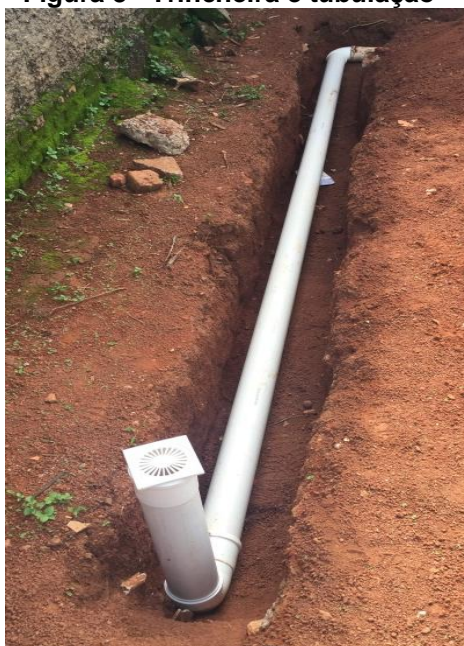
Figura 3 - Trincheira e tubulação
