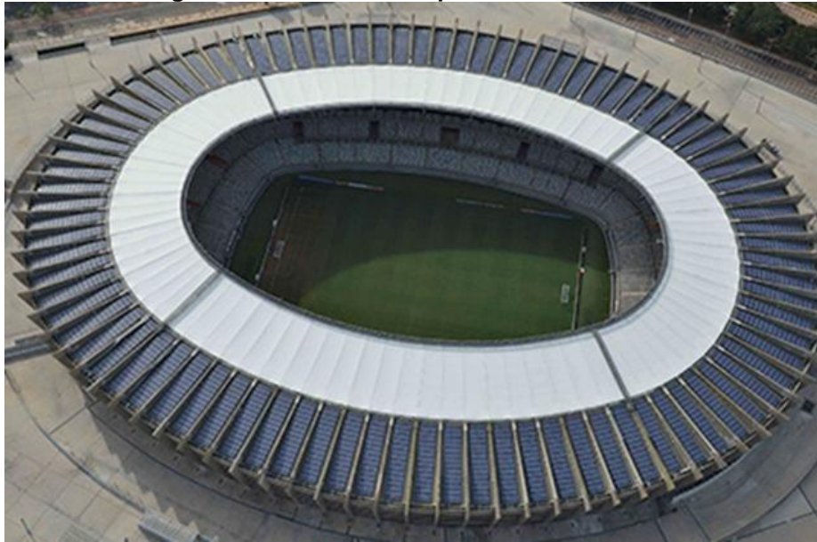
Figura 2– Cobertura com painéis fotovoltaicos.
