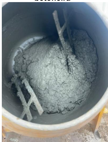
Figura 3 - Mistura dos materiais na betoneira
