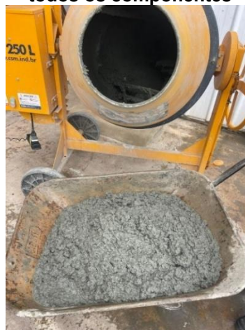
Figura 4 - Mistura final do concreto após adição de todos os componentes
