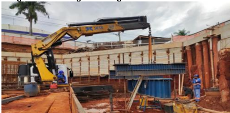
Figura 03 – Montagem das vigas metálicas do ensaio PCE
