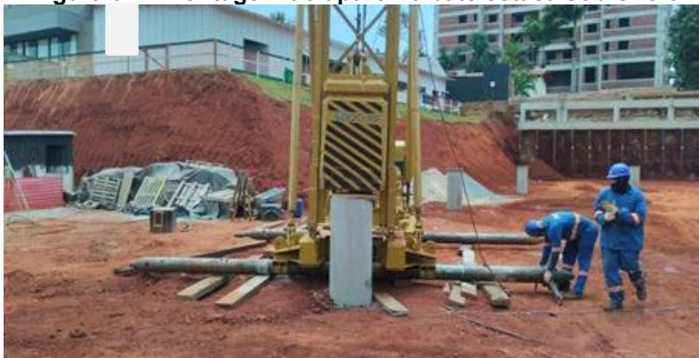
Figura 01 – Montagem do aparelho bate estaca sobre rolo
