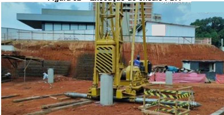
Figura 02 – Execução do ensaio PDA
