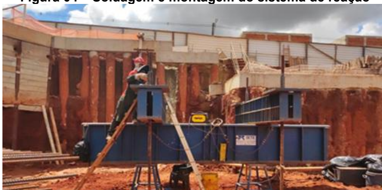
Figura 04 – Soldagem e montagem do sistema de reação
