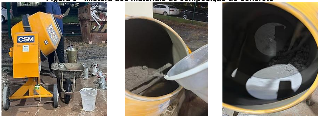
Figura 5 - Mistura dos materiais de composição do concreto
