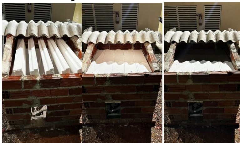
Figura 8 – Detalhes do telhado
