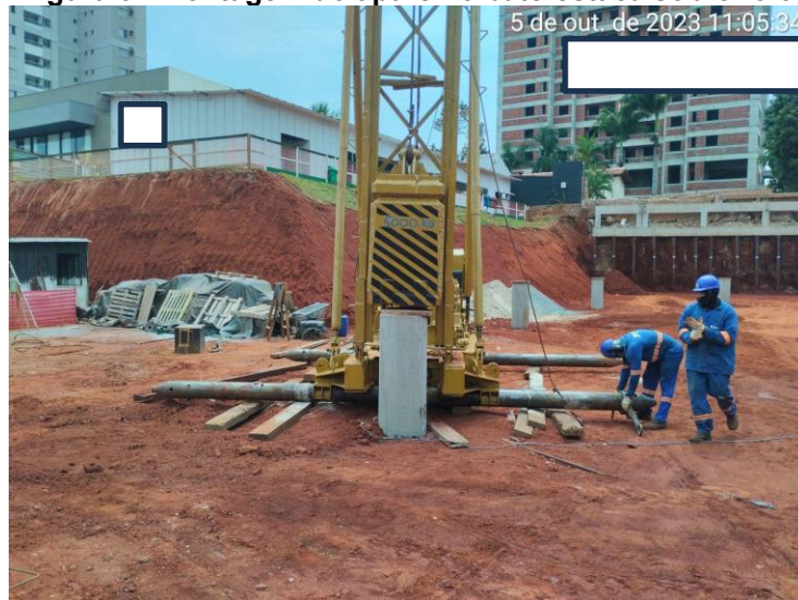
Figura 6 - Montagem do aparelho bate-estaca sobre rolo
