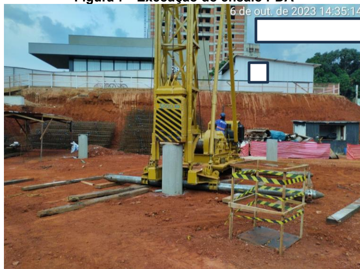
Figura 7 - Execução do ensaio PDA
