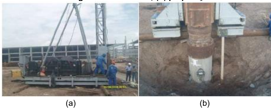
Figura 5 - (a) Aparelho “bate estaca” utilizado no ensaio de carregamento dinâmico; (b) preparação
