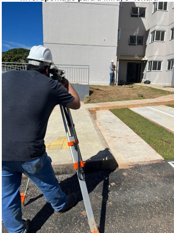
Figura 14 – Mira apoiada no bloco B, e o nível apontado para a mira, 3ª leitura
