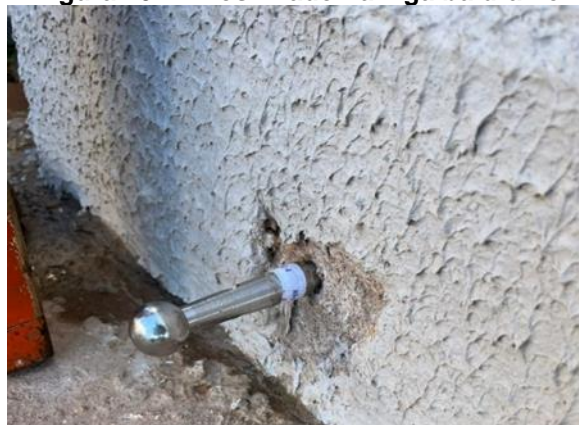
Figura 10 - Pinos fixado na viga baldrame
