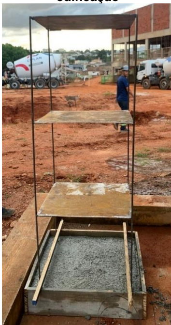
Figura 8 – Estrutura da edificação
