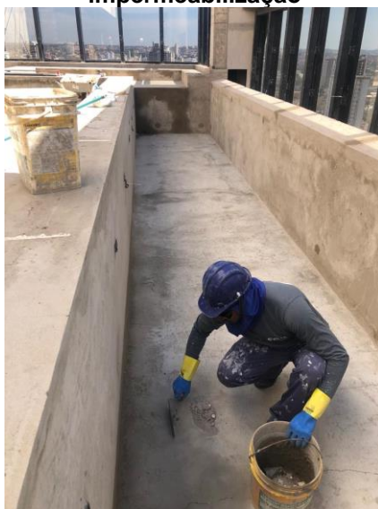
Figura 33 - Limpeza pré impermeabilização
