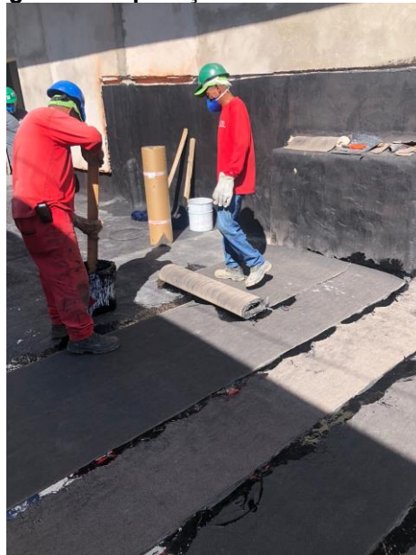
Figura 18 - Aplicação da manta asfáltica
