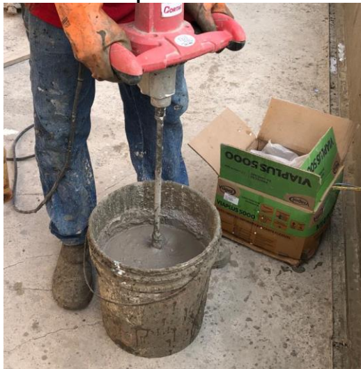
Figura 34 - Preparação da argamassa polimérica
