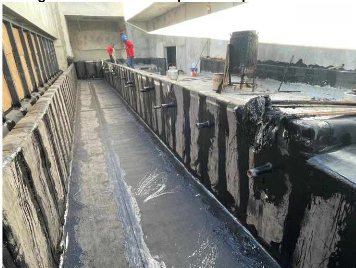
Figura 24 - Estrutura da piscina Impermeabilizada
