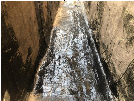
Figura 30 - Local do vazamento 2 após recomposição
