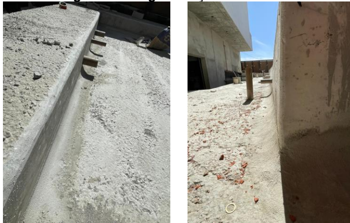
Figura 22 - Regularização da estrutura
