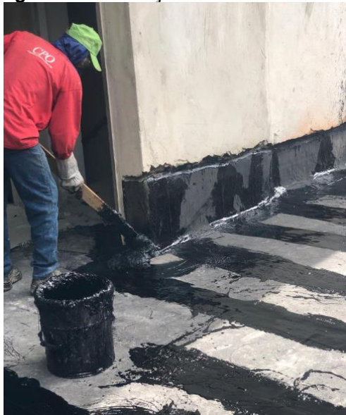
Figura 19 - Execução do banho asfáltico
