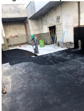
Figura 15 - Execução da imprimação da laje do pavimento lazer
