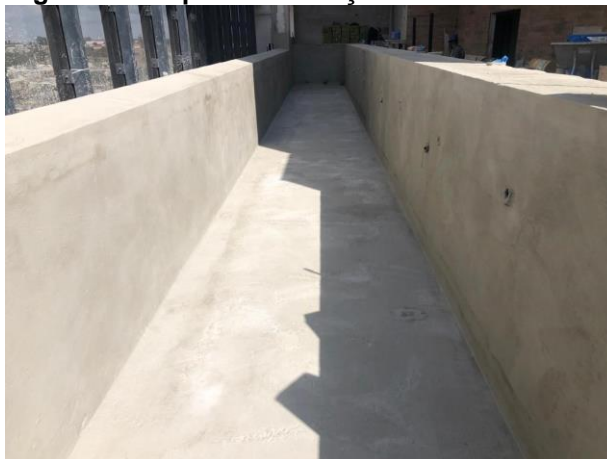
Figura 38 - Impermeabilização finalizada
