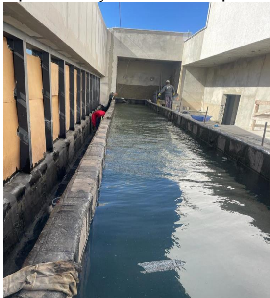
Figura 25 - Teste de estanqueidade da impermeabilização da estrutura da piscina
