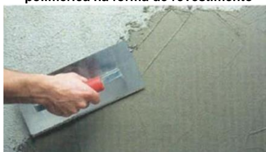
Figura 4 - Aplicação de argamassa polimérica na forma de revestimento
