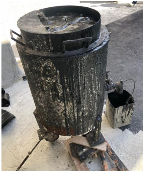
Figura 17 - Aquecimento do cimento asfáltico
