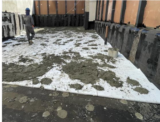
Figura 21 - Proteção da manta asfáltica com EPS
