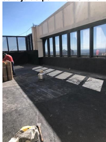
Figura 15 - Execução da imprimação da laje do pavimento lazer
