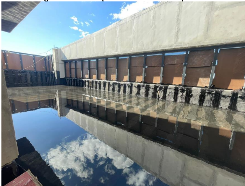
Figura 20 - Execução do teste de estanqueidade
