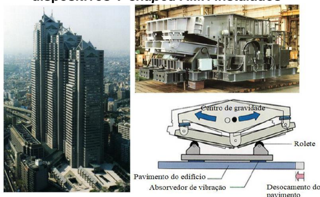
Figura 5 - Sistema de controle híbrido: à esquerda o Edifício Shinsuku Park Tower e à direita um dos dispositivos V-shaped AMH instalados
