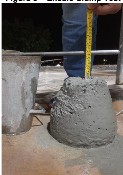
Figura 5 – Ensaio Slump Test
