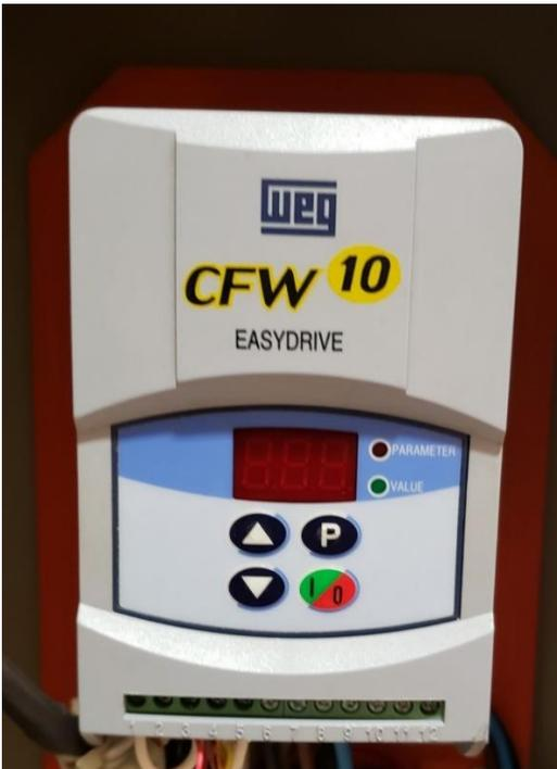
Figura 9 - Inversor de frequência
