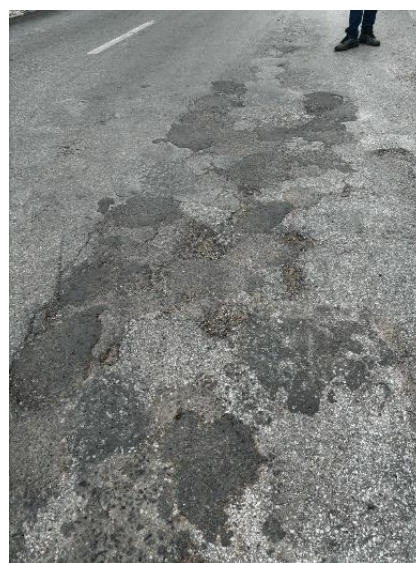
Figura 10 – Remendo.
