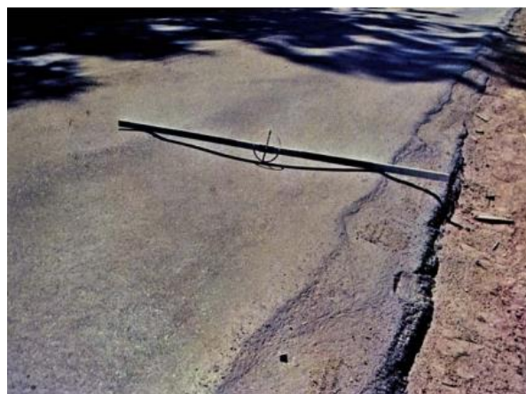
Figura 4 – Afundamento [9]
