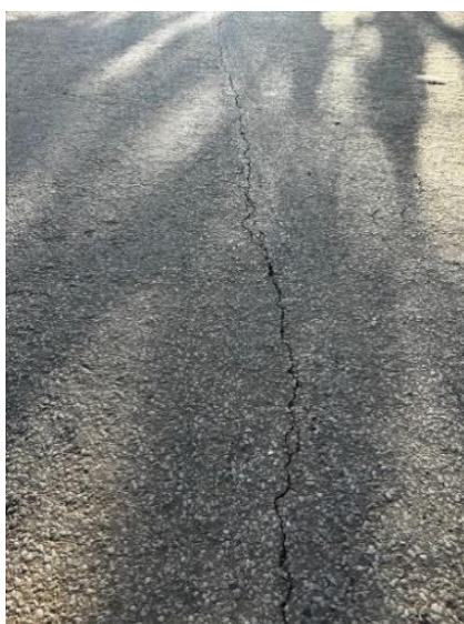
Figura 12 – Trinca longitudinal.
