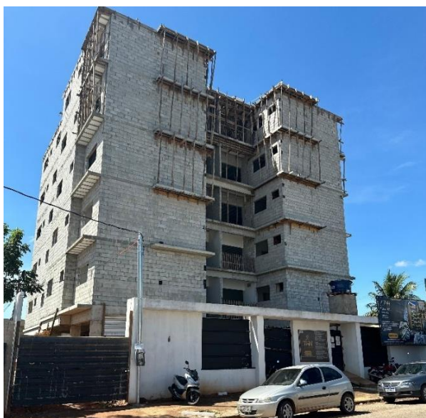
Figura 4 - Fachada da Edificação
