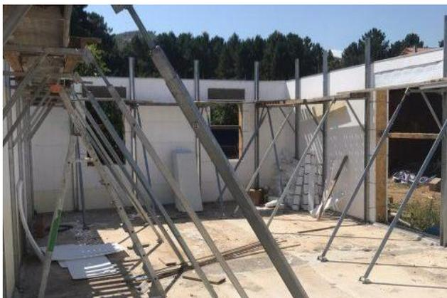
**Figura 3:** Instalação de aprumadores [22].
