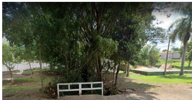
Figura 7 - Área do córrego mostrando erosão, assoreamento e alagamento em períodos de chuva.
