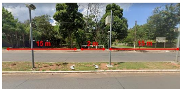
Figura 5 - Região degradada com problemas de assoreamento e erosão
