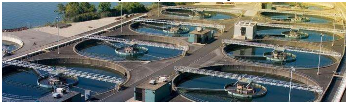
Figura 2 – Estação de tratamento de água
