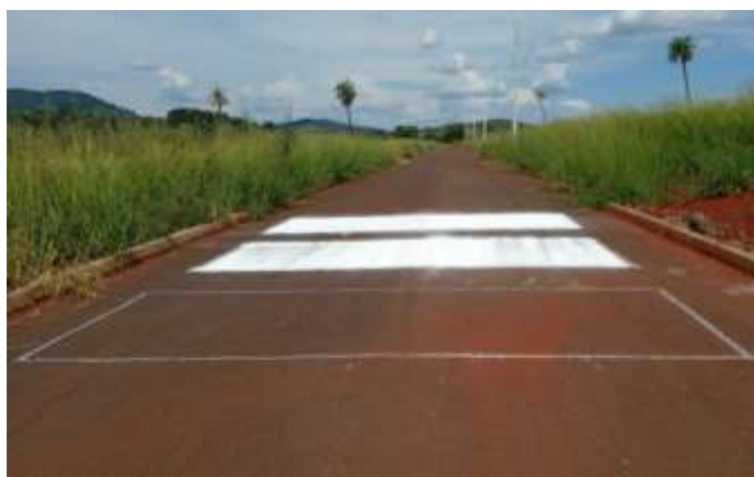
Figura 3: Pavimento após a aplicação das tintas.
