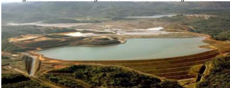
Figura 8- Talude da barragem Casa de Pedra em Congonhas-MG
