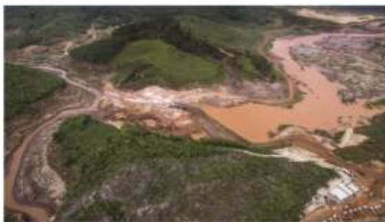
Figura 1-Rompimento da barragem de Fundão em Mariana-MG no ano de 2015
