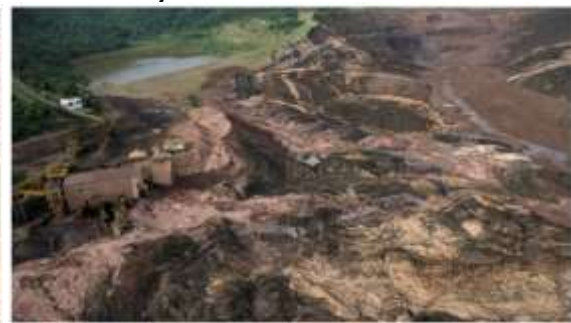
Figura 2-Rompimento da barragem do Córrego do Feijão em Brumadinho-MG
