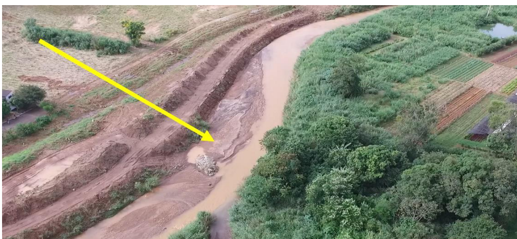
Figura 04 – Assoreamento Água Fria/Antas
