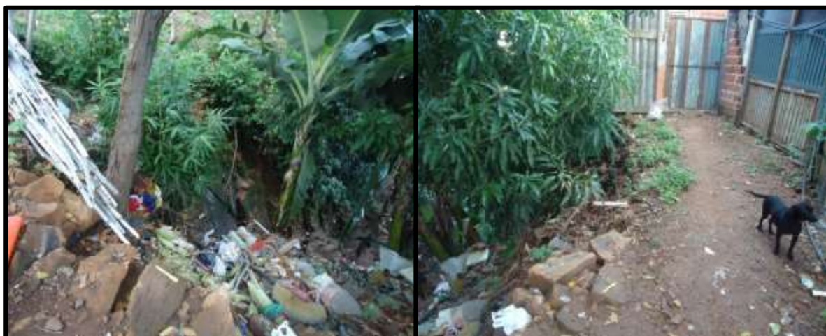
Figura 01. Erosão no bairro Novo Paraíso, Anápolis-GO.
