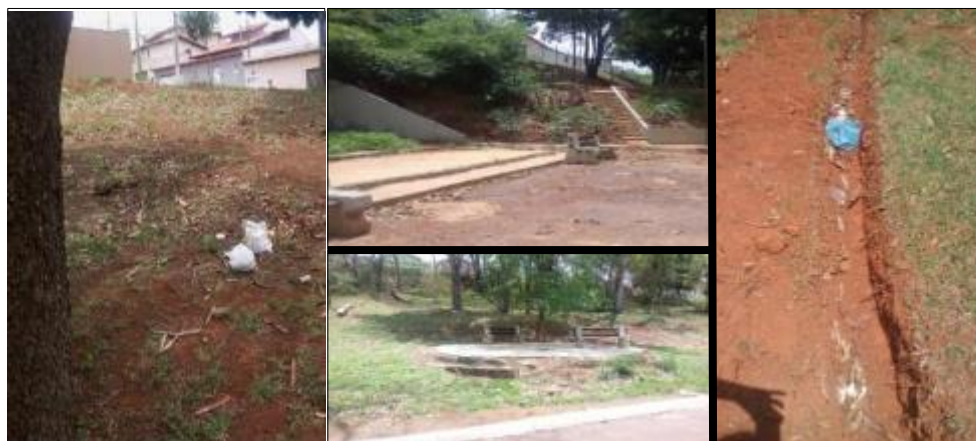
Figura 4 – Desgaste da estrutura do parque
